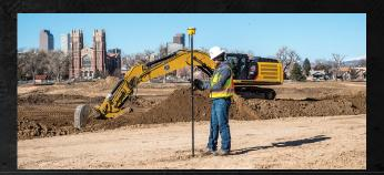
Das Trimble Siteworks Positionierungssystem für die Baustellenvermessung besteht aus der SPS986 oder SPS785 GNSS Smart Antenne, dem TSC7 Controller oder T7 Tablet und der Siteworks Software. Es ermöglicht Bauvermessern, mit komplexen 3D-Modellen zu arbeiten, große Datenmengen schneller zu erfassen, komplexe 3D-Modelle einfacher zu visualisieren und unabhängig von Lichtverhältnissen effizienter zu arbeiten.
